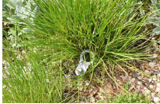
Obr. 10: Kotevní bod je zakryt vegetací
