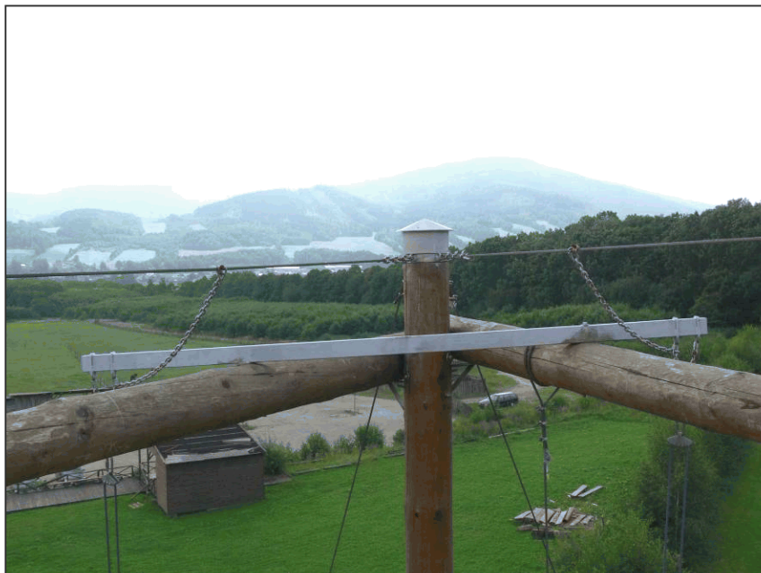
Obr. 5 Upevnění traverzy
